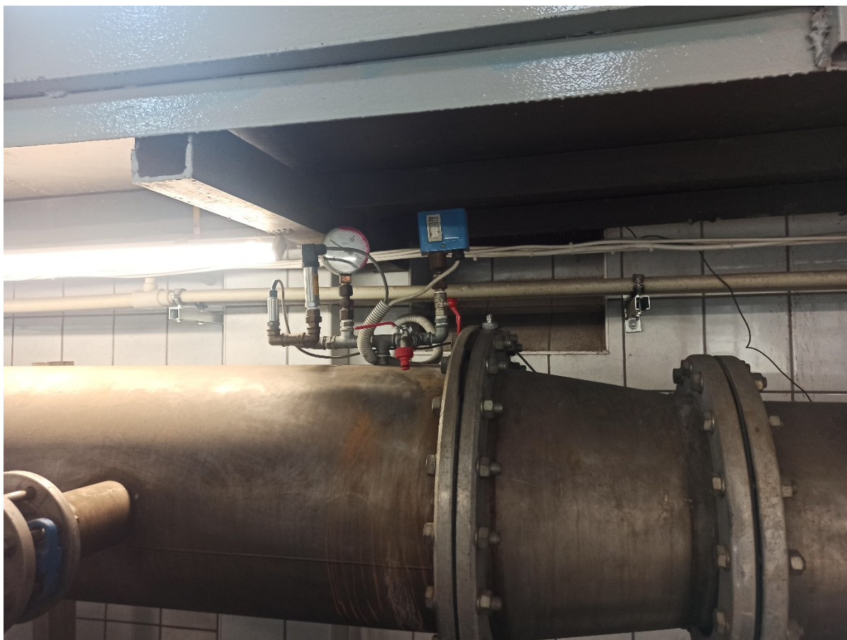
Rysunek 7 Miejsce montażu urządzenia do pomiaru zawartości chloru wolnego
