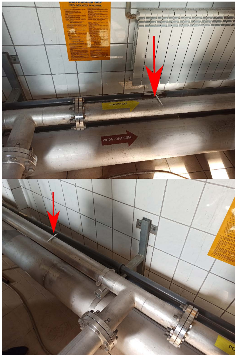
Rysunek 2 Miejsce montażu przepływomierzy powietrza
