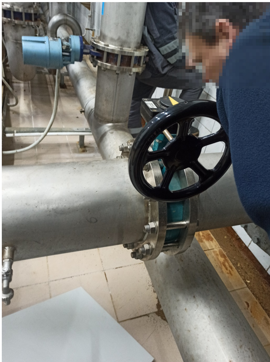
Rysunek 4 Miejsce montażu napędu do przepustnicy DN250
