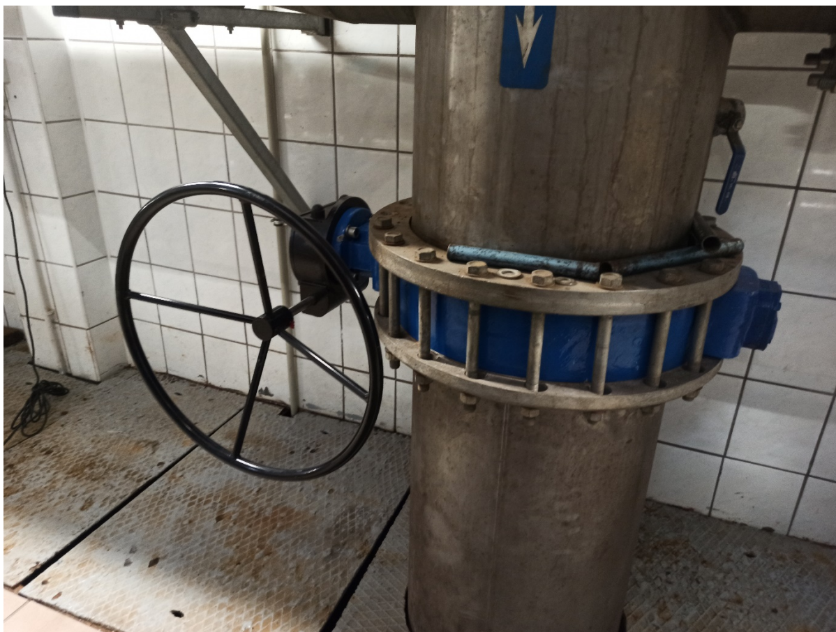
Rysunek 5 Przepustnice DN500
