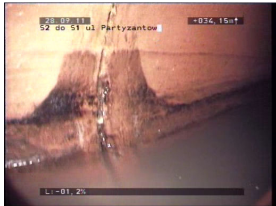
Fot. 1 Infiltracja wód gruntowych wraz z gruntem
