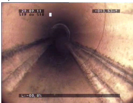
Fot. 41 Pęknięcia obwodowe i złożone
