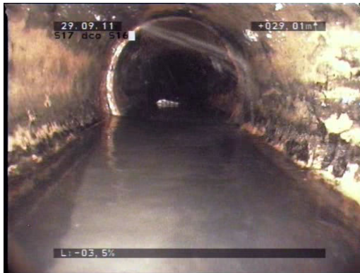
Fot. 34 Infiltracja wód gruntowych poprzez nieszczelne złącze rur
