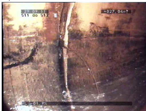
Fot. 24 Infiltracja wód gruntowych poprzez nieszczelne złącza
