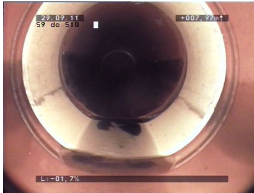
Fot. 17 Zmiana materiału konstrukcyjnego rur
