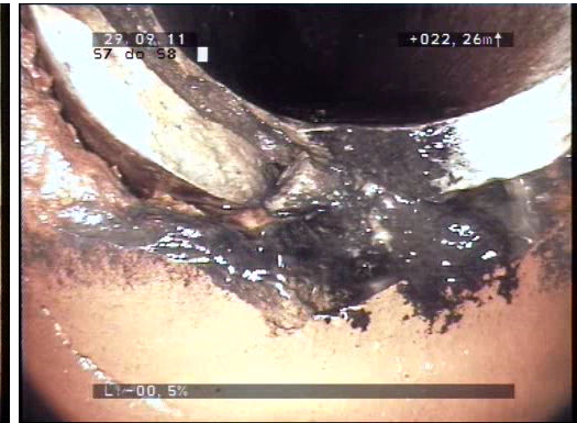
Fot. 12 Infiltracja wód gruntowych w miejscach nieprawidłowo włączonych przykanalików
