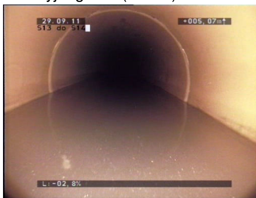
Fot. 29 Zmiana materiału konstrukcyjnego rur
