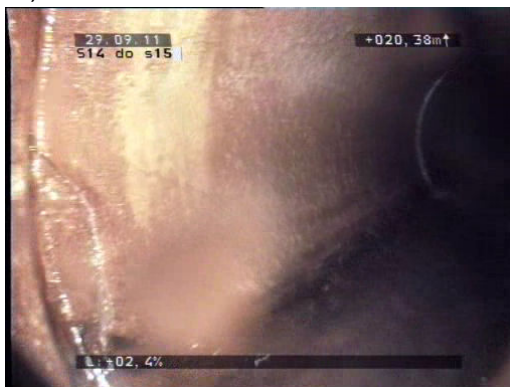
Fot. 30 Infiltracja wód gruntowych poprzez nieszczelne złącza rur
