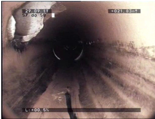
Fot. 12 Infiltracja wód gruntowych w miejscach nieprawidłowo włączonych przykanalików
