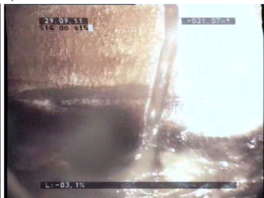
Fot. 30 Infiltracja wód gruntowych poprzez nieszczelne złącza rur
