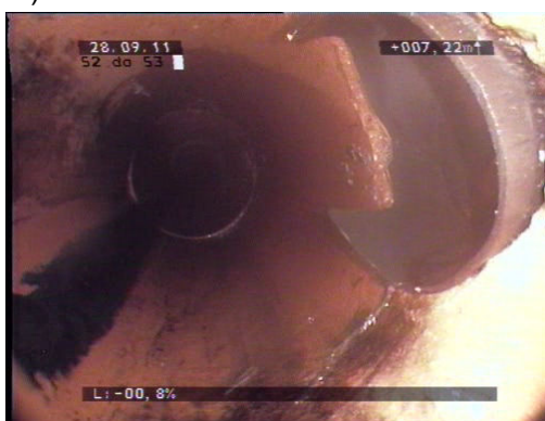
Fot. 3 Infiltracja wód gruntowych w miejscach nieprawidłowo włączonych przykanalików
