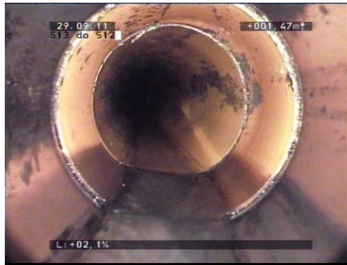
Fot. 28 Zmiana materiału konstrukcyjnego rur
