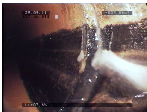
Fot. 36 Infiltracja wód gruntowych poprzez nieszczelne złącza rur
