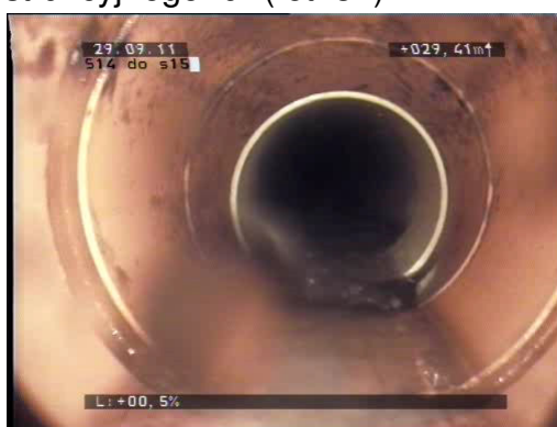
Fot. 32 Zmiana materiału konstrukcyjnego rur
