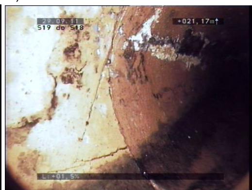
Fot. 41 Pęknięcia obwodowe i złożone
