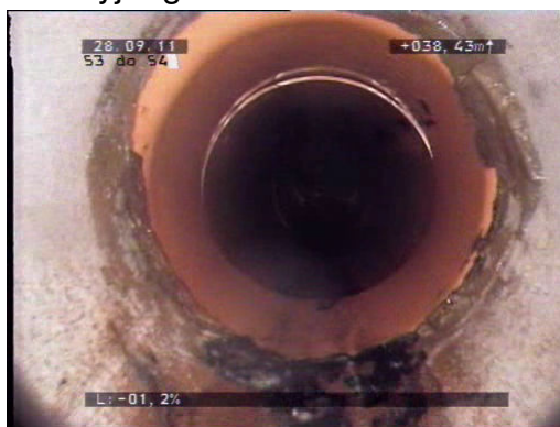
Fot. 6 Zmiana materiału konstrukcyjnego rur
