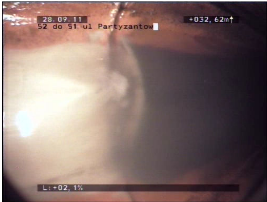
Fot. 1 Infiltracja wód gruntowych wraz z gruntem
