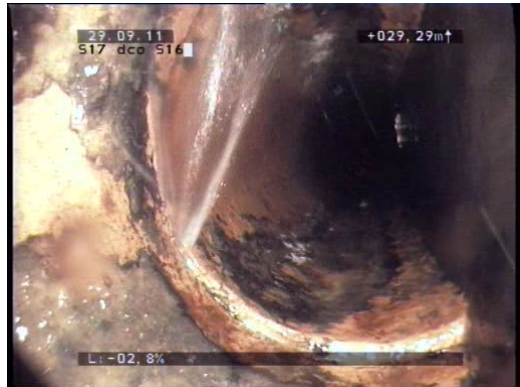
Fot. 34 Infiltracja wód gruntowych poprzez nieszczelne złącze rur
