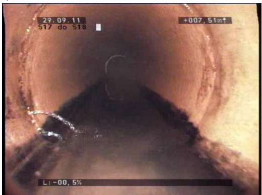
Fot. 36 Infiltracja wód gruntowych poprzez nieszczelne złącza rur
